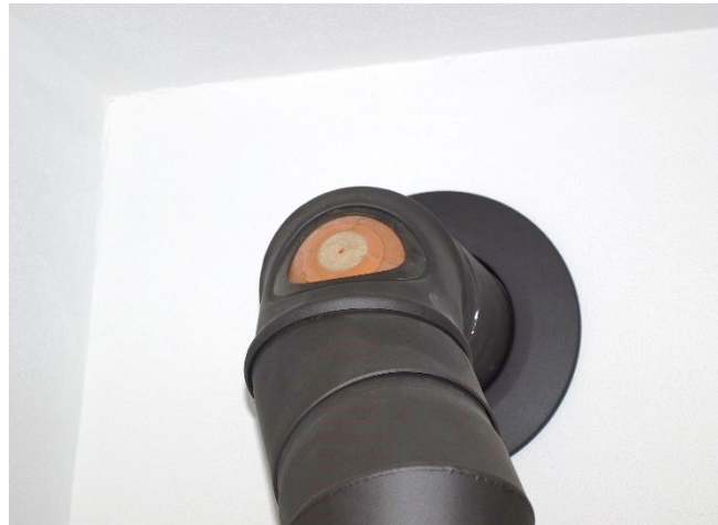
Abbildung 5: Rauchrohr eines Kaminofens zum Blower-Door-Test über die geöffnete Serviceklappe mit einer Ballblase verschlossen.
