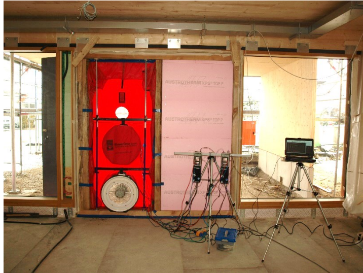
Abbildung 1: Messaufbau mit 2 tragbaren BlowerDoor-Ventilatoren an einem Gebäude weit vor Fertigstellung
