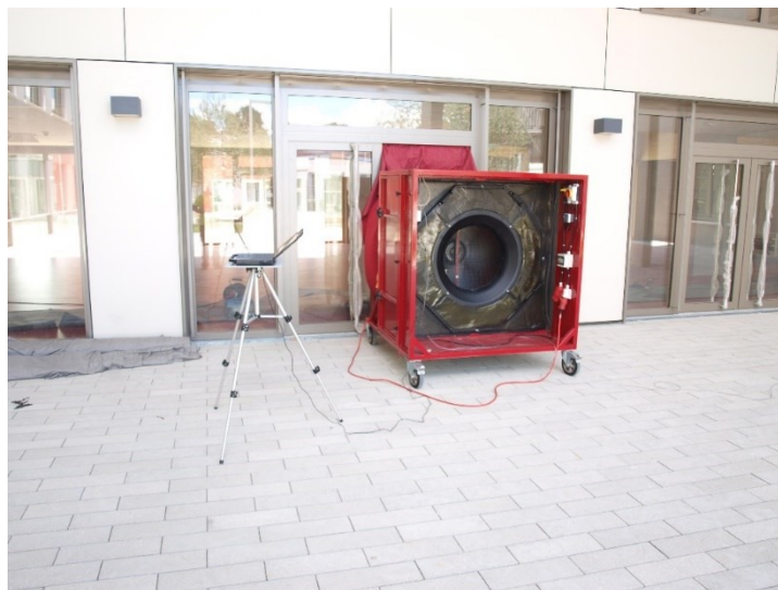
Abbildung 3: ... und außen für Überdruck. Sehr gute Zugänglichkeit durch fertiggestellte Außenanlagen.
