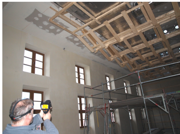
Luftdichtheitsprüfung / Blower-Door-Test am historischen Kopfbau des Neumarkter Turnerheims kurz vor Fertigstellung der Sanierung. Überprüfung der Gebäudehülle auf Luftleckagen mit der Wärmebildkamera bei Unterdruck im Gebäude.
